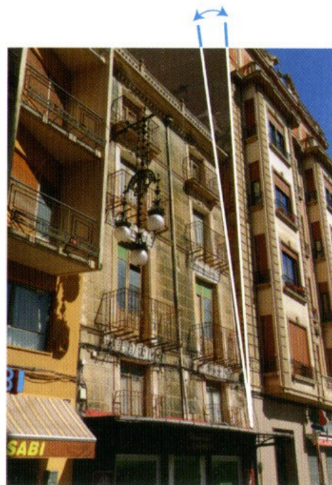
figura 37 - Edificio basculado en Plaza Nueva (Orihuela), situada en las proximidades del río Segura.
