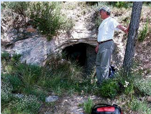
Foto 1) Entrada al refugio excavado en arcillas.
